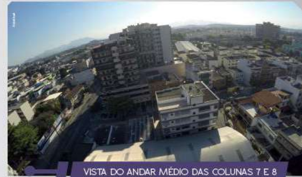
VISTA DO ANDAR MÉDIO DAS COLUNAS 7 E 8
