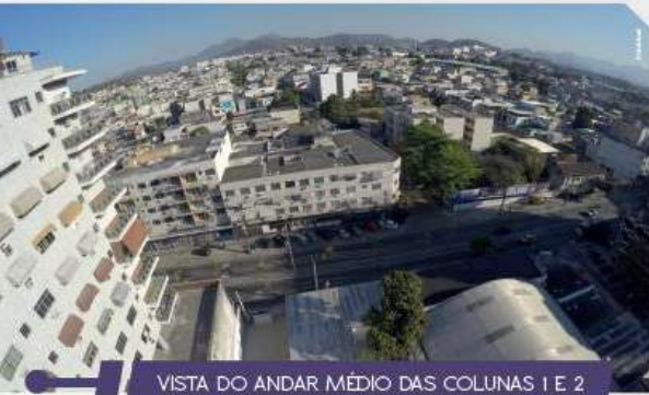
VISTA DO ANDAR MÉDIO DAS COLUNAS 1 E 2
