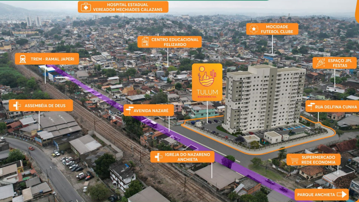
Foto aérea do local
